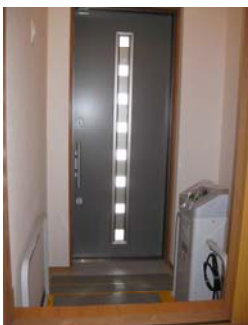
段差昇降機設置
